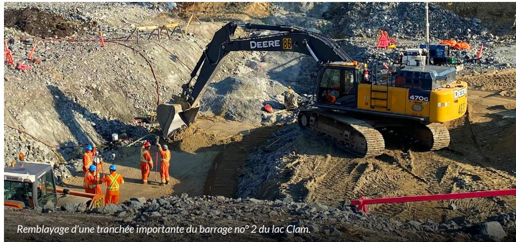
Remblayage d'une tranchée importante du barrage no° 2 du lac Clam.
